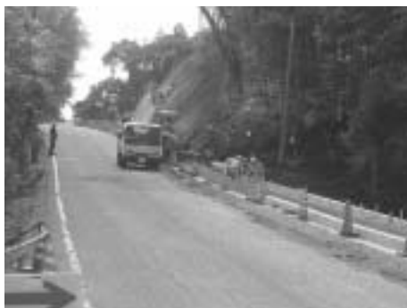
町道平原深江港線舗装改良工事(大神後村)
