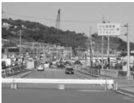
国道10号線拡幅工事(日出警察署前)
