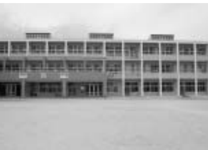
大神小学校の新校舎の完成
