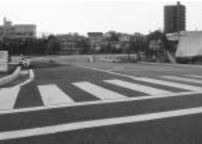
日出陽谷高校跡地入り口の拡幅工事
