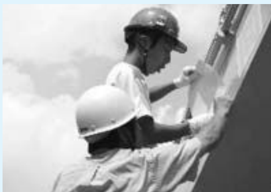
看板の取り付け作業を体験する生徒
