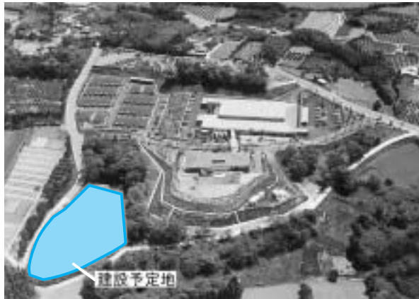
ホンダ太陽新工場建設予定地
